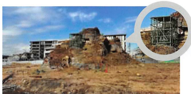
伐採後の状況1(南側から撮影)
