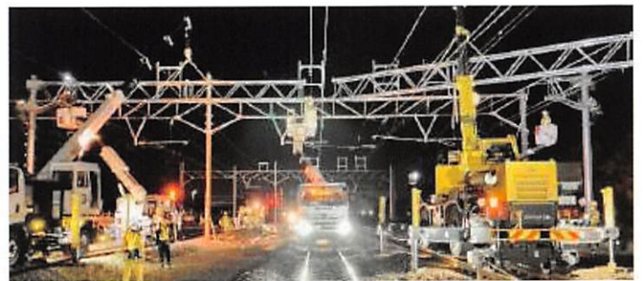
新駅工事の様子
